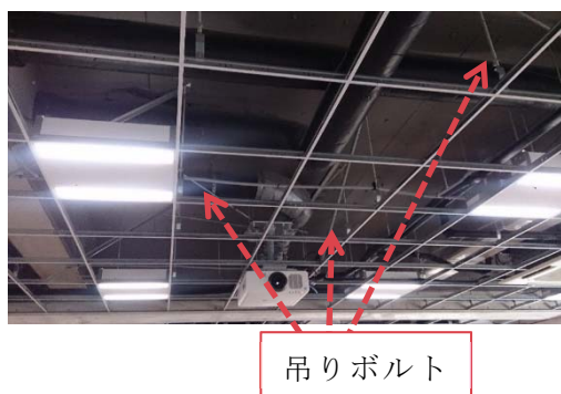
図 4-1 吊りボルトへのマーカー設置イメージ 得られた結果
