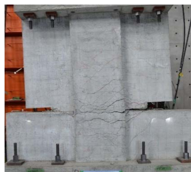
図 3-3 最終破壊状況
